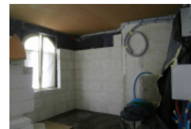
Test d'étanchéité et isolation avec matériaux perspirants : efficacité énergétique durable. © V.Comito
